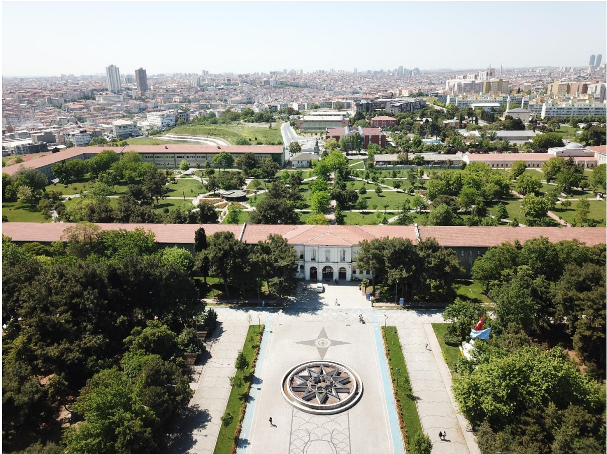
Rektörlük Binası, Davutpaşa Yerleşkesi
